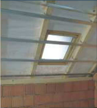
Zabudowa poddasza na profilach kapeluszowych
